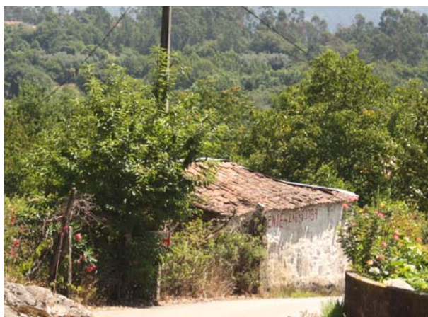
Fotografia 4 – Edifício em Ruína a 17 metros do eixo da linha
