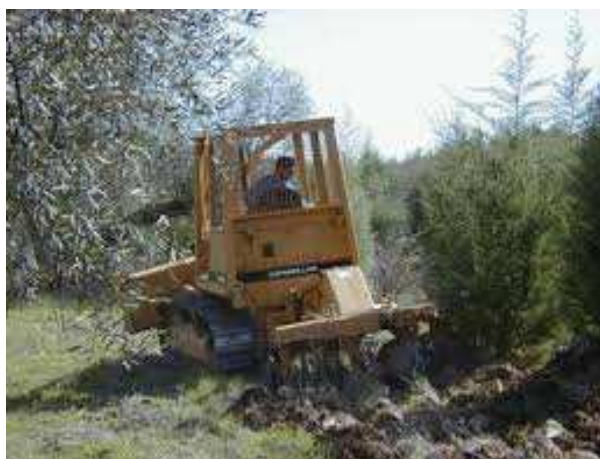
Figura 30 - Limpeza de matos mecânica: gradagem
