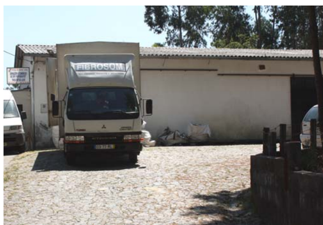
Fotografia 5 – Pavilhão de atividade industrial a 55 metros do eixo da linha
