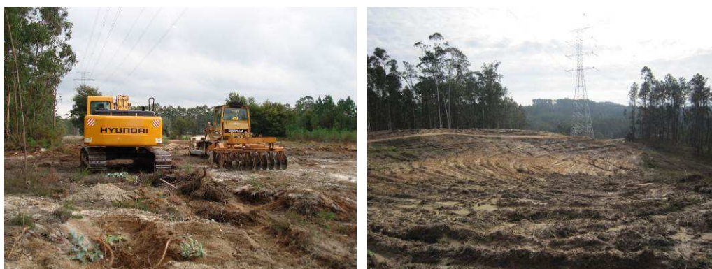
Figura 37 - Preparação do terreno para plantação
